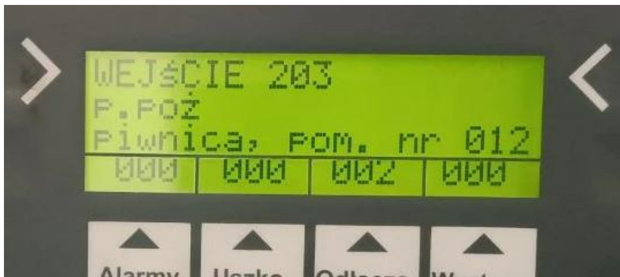
Fot. nr 1 – Kłapa ppoż. w odłączeniu
