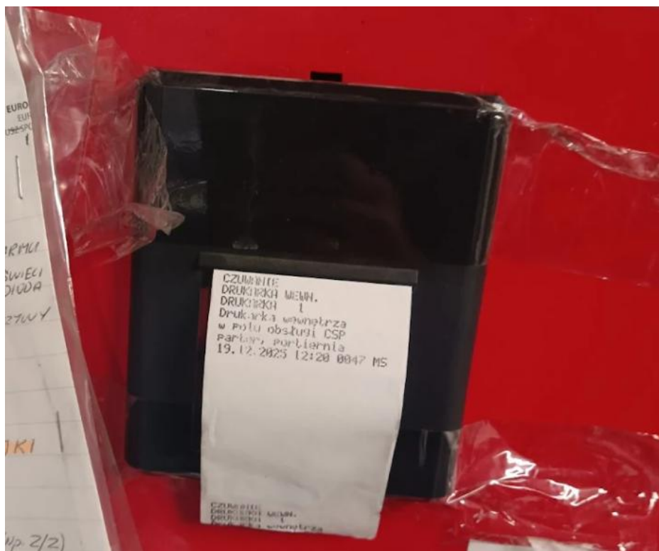
Fot. nr 3 – Uszkodzona obudowa drukarki centrali sygnalizacji pożarowej
