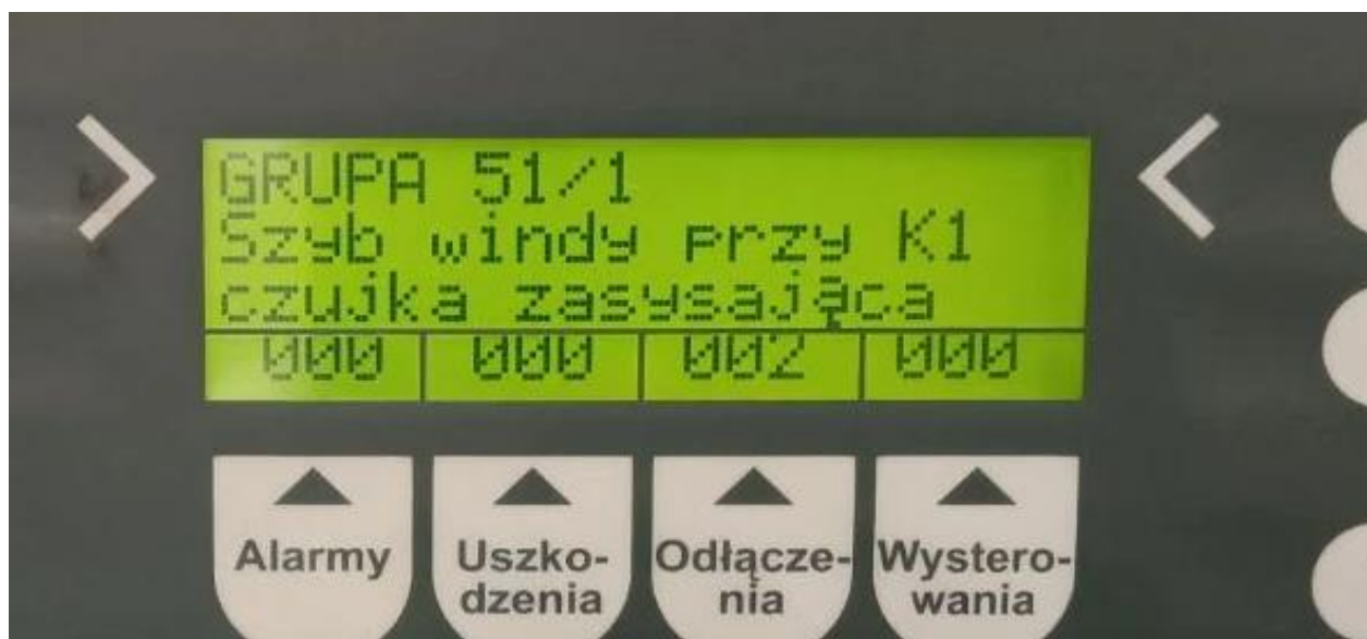
Fot. nr 2 – System zasysający ASD 51/1 w awarii
